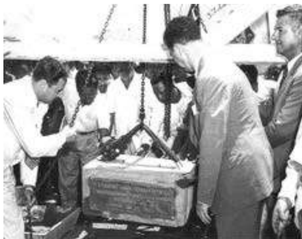
Colocación de la primera piedra del Instituto Tecnológico de Veracruz
